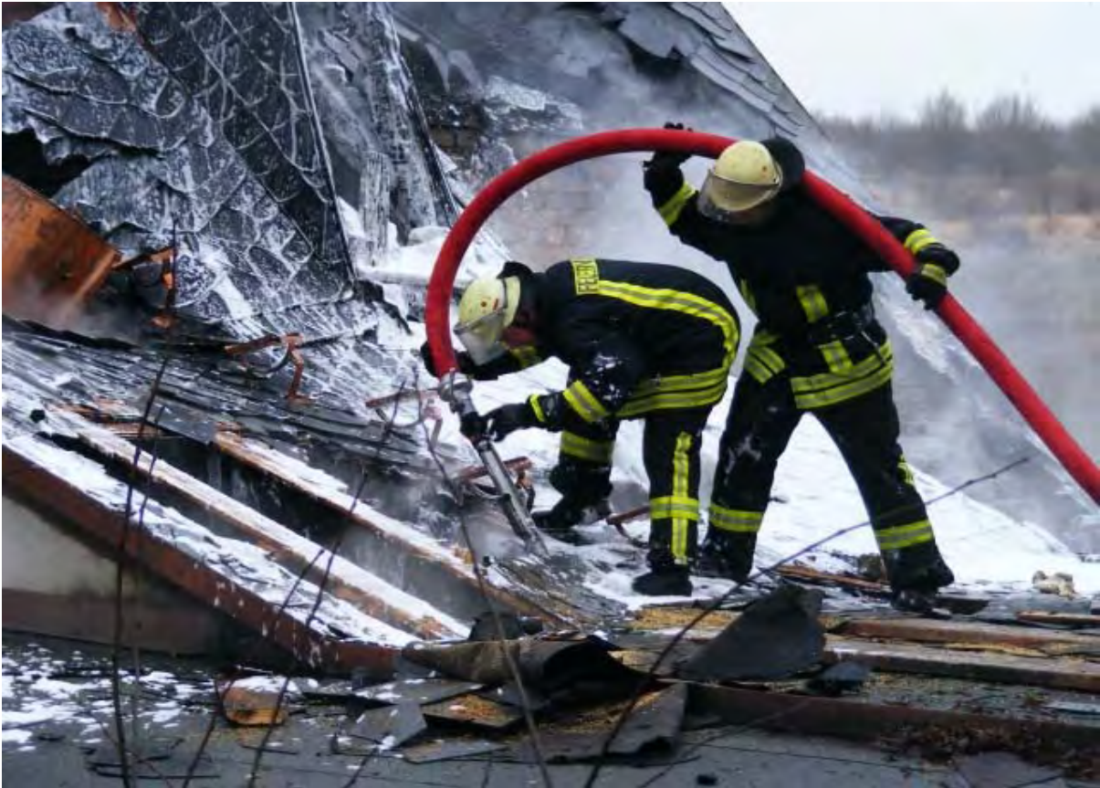
11.03.2012 – Nachlöscharbeiten bei Brand eines Einfamilienhauses in Zschipperrn
